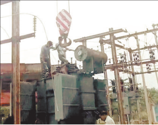
पाँवर ट्रांसफार्मर को क्रेन के माध्यम से निकालते विद्युत कर्मी।
